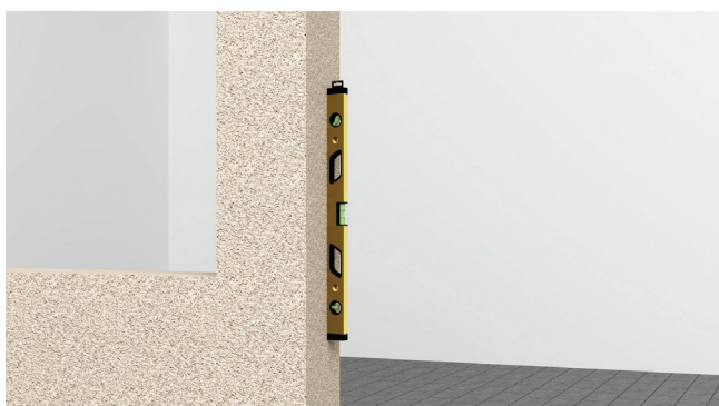
2 Contrôler les niveaux des 2 piliers;
