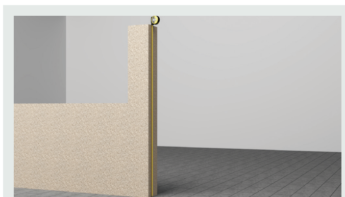
5 Mesurer en haut. Retenir la plus petite mesure;
